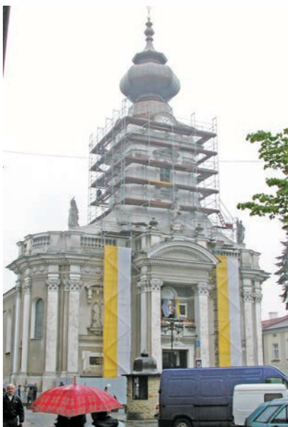
正在維修的瓦多維斯教堂
