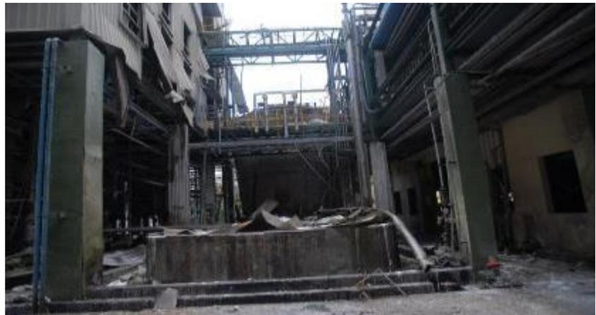
次事故非該場於製成作業時發生，而係該場為改善老舊設備、管線及強化安全防護措施施工所發生之公安事故，雖該場於停工時即將儲槽內之危險物品溶劑抽出，惟未使用惰性氣體使儲槽及管線無殘餘之可燃性蒸氣即動火施工；且於現場勘查時發現大循環管線有使用乙炔氧切割後的痕跡以及管線內部之保溫材有燻黑的情形，該場動火施工顯有違失。故建議該公司加強儲槽、管線歲修作
