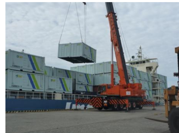
200トントラッククレーン
